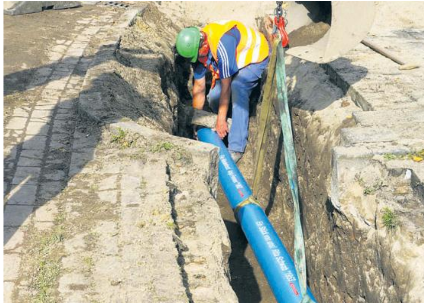
Ein Stück von uns*. Die ersten (unsichtbaren Worte*) sind in der Bürgermeister-Deichmann-Straße installiert worden.
